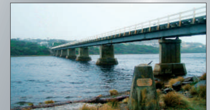
Puente sobre el río Arthur - Australia
