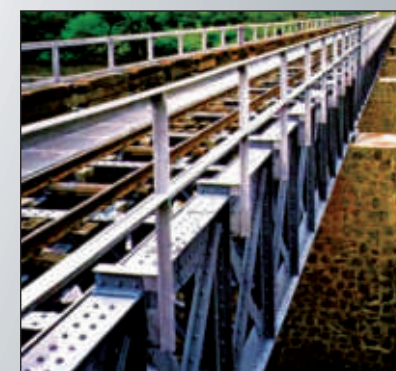
Puente Ouémé - Benin
